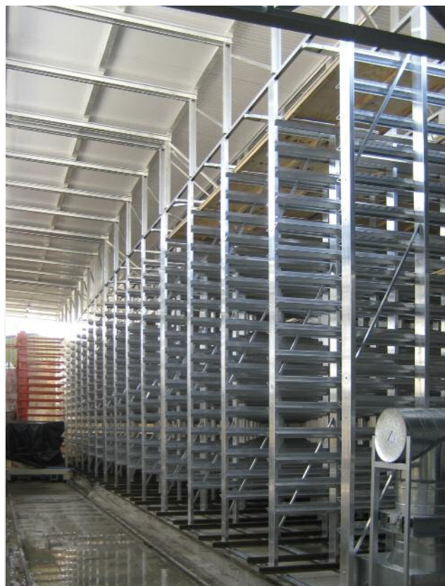
Надежность хранения и простота доступа для тележки – высокий боковой буртик опорного профиля препятствует столкновению со стальными подпорками.
