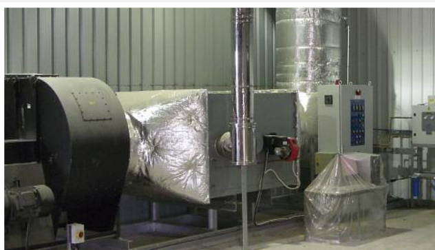
Системы циркуляции воздуха создают необходимые условия для поддержания постоянной температуры внутри сушильной камеры и распределения влажности
