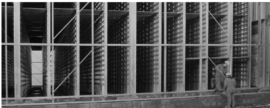
Stahlskelett der Halle mit Härte- und Trockenkammer; die Verkleidung erfolgt später – Montage kein Problem
